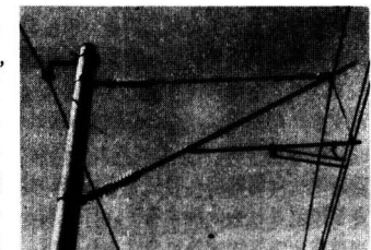
写真-4 東海道新幹線用振れ止め
