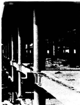
写真-2 同上使用のラーメン 構造の新大駅
