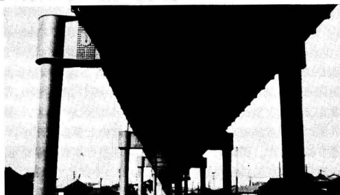
写真-3 同上使用の鉄道橋ラーメン脚 (田島二郎)
