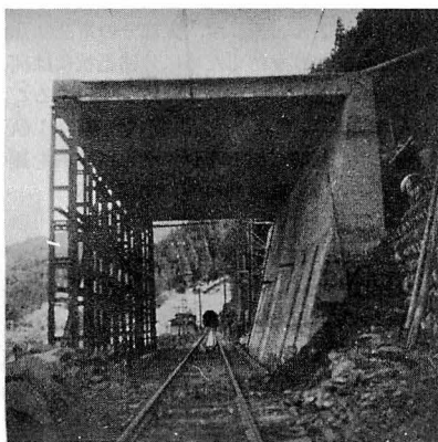
2. PSコンクリート版を使用せる落石覆
