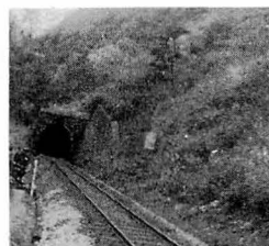
3. トンネル坑口翼壁
