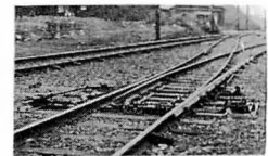
双動転てつ器 (複式転てつ換および鎖錠装置を設備したもの)
