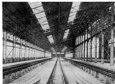
2. 高電圧電車庫(内部)
