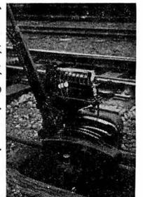
2. 電気鎖錠器取付図(H型)
