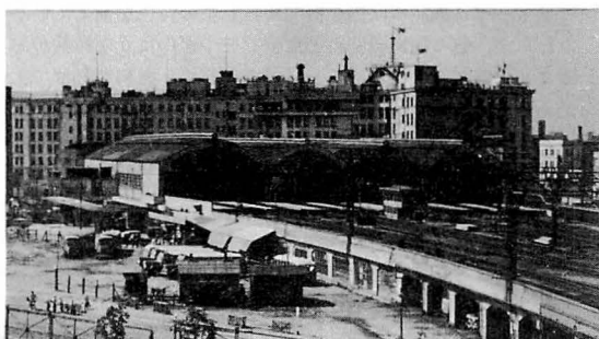
2. ドーム式乗降場上家を有する停車場の例 (南海電鉄難波駅)
