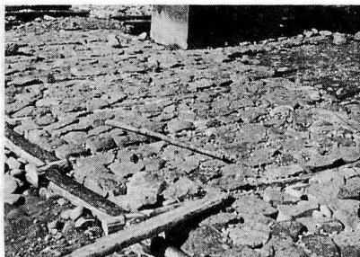
木工沈床上面の張石
