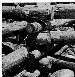
木工沈床方格材の組立
