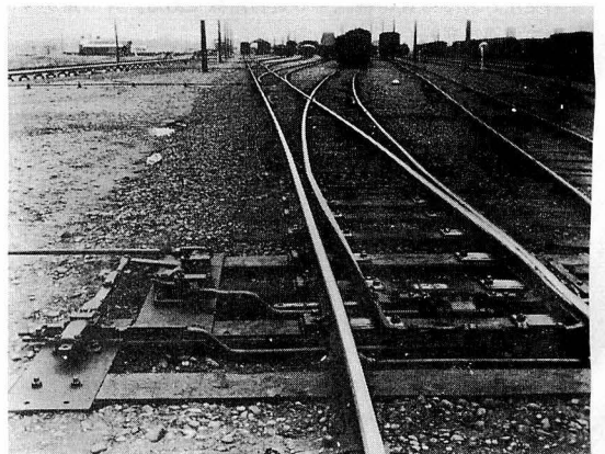
単式鎖錠装置(エスケープクランク併用)
