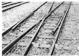
写真-2. 分岐器護輪軌条
