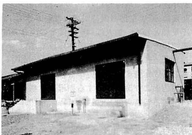
奈良自動車区危険品庫
