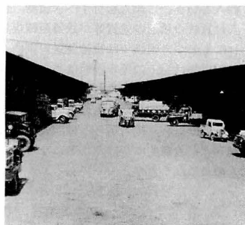
1. 貨物通路（梅田駅1・2号ホーム間）
