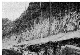
護岸擁壁部洗掘例
