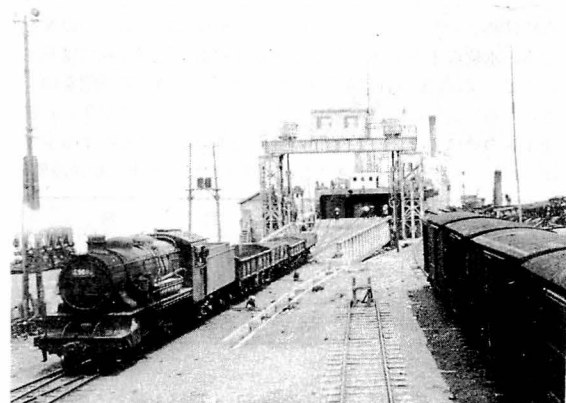
写真-4. 可動橋 (車両航送用・青森)
