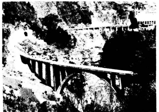
4. 鉄筋コンクリートアーチ橋(氷川線日原川)
